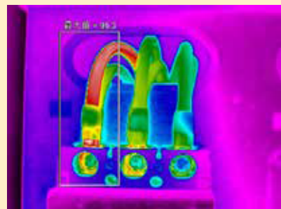
電氣線纜超載三相不平衡
