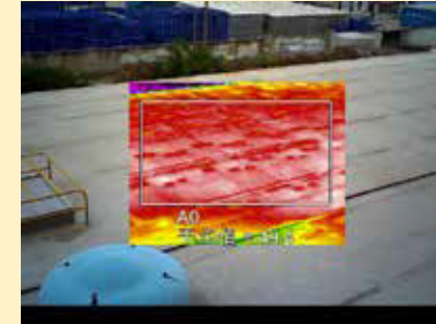
對帶有保溫材料的屋頂鋪設進行品質檢驗 (室外溫度 35 °C)
